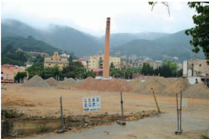
Vista actual dels terrenys de la Fàbrica
