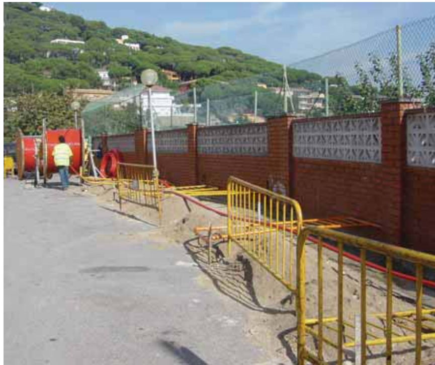
Les obres de soterrament ja han començat al barri del Remei
