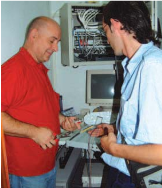
Operaris instal·len la fibra òptica a l'Ajuntament
