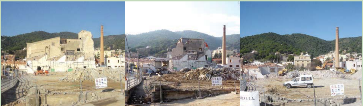
Poc més d'una setmana separen aquestes tres fotos. És el temps que va ser necessari per enderroc totalment l'estructura principal de «La Fàbrica», a començaments de febrer. Quan acabin definitivament els treballs d'enderroc, només la xemeneia romandrà intacta
