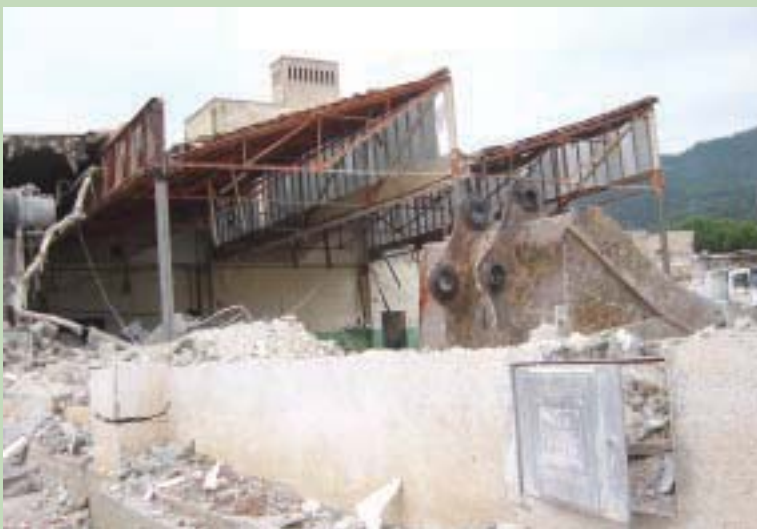
Aspecte recent dels treballs d'enderrocament de 'La Fàbrica'
